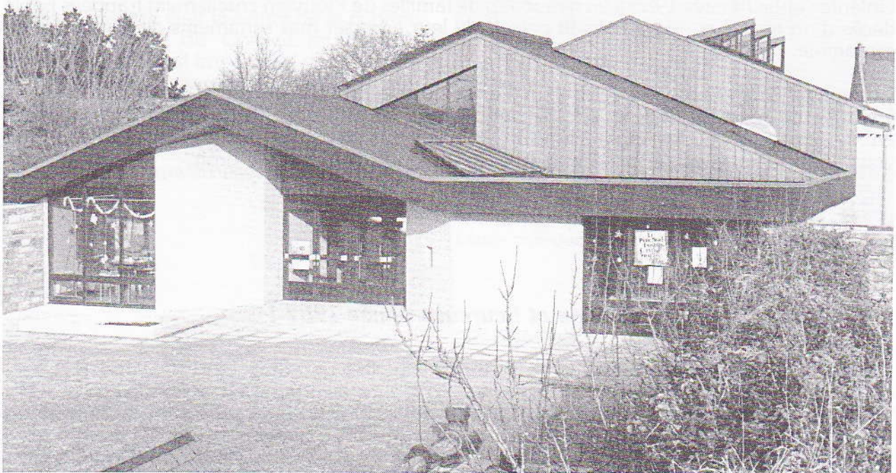
La salle polyvalente, une réalisation à la mesure du dynamisme de Plouvien.
