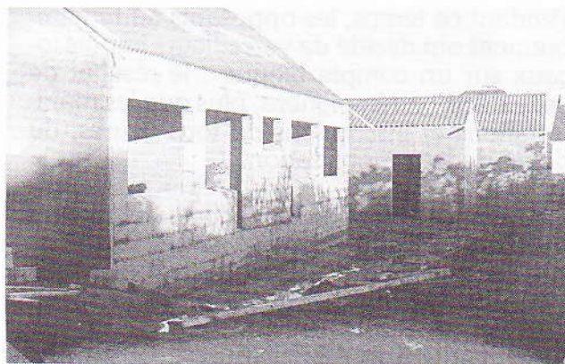
L'école Saint-Jaoua en chantier
