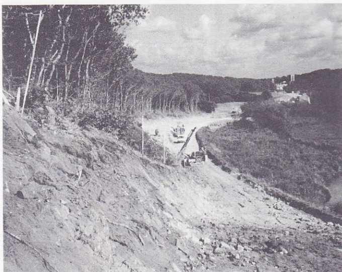
Le chantier de la route Plouvien-Tariec
