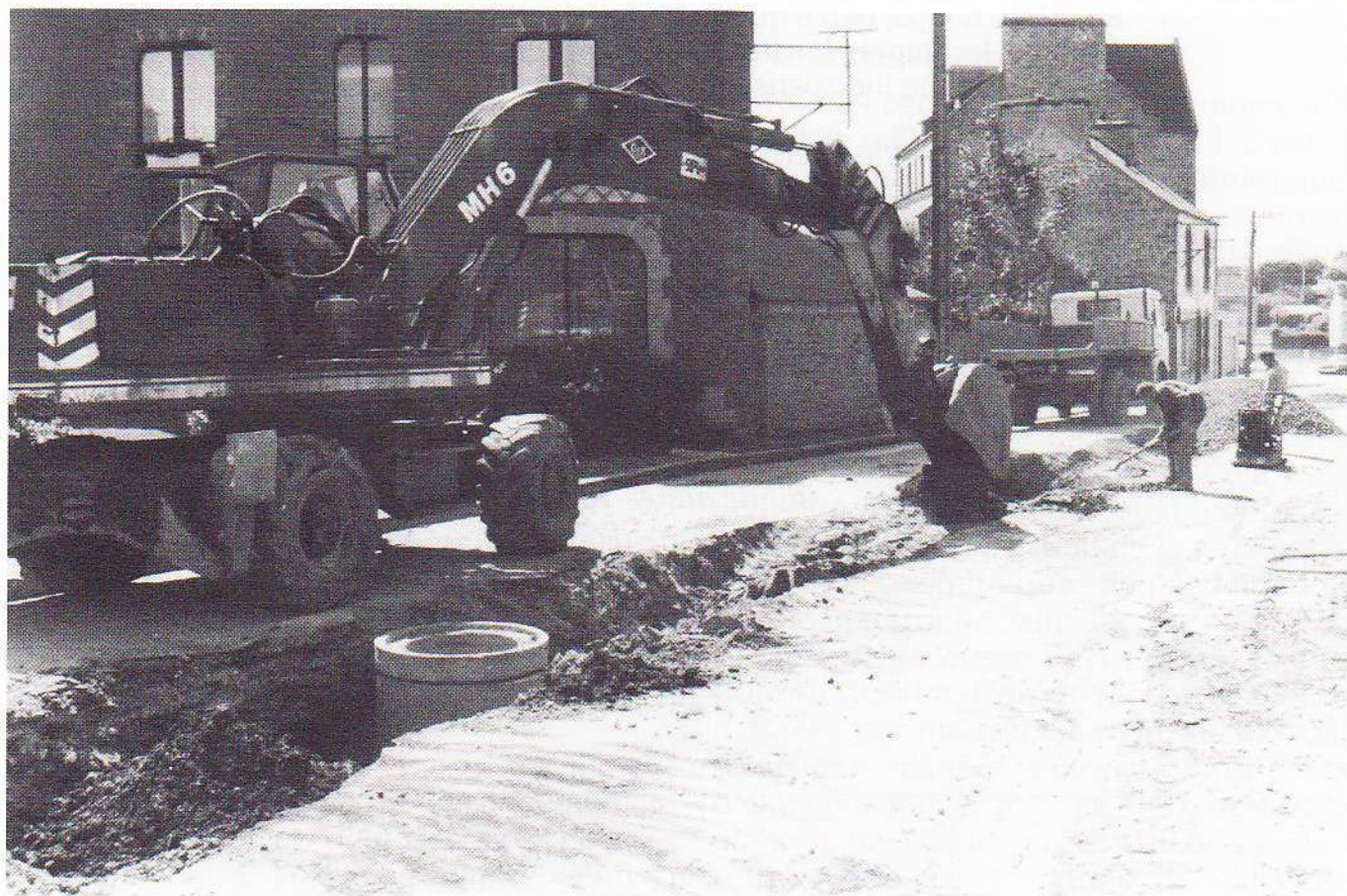
1990 : année de grands travaux Ci-dessus : l'assainissement collectif
