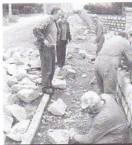
Confection d'un muret, rue Laennec
