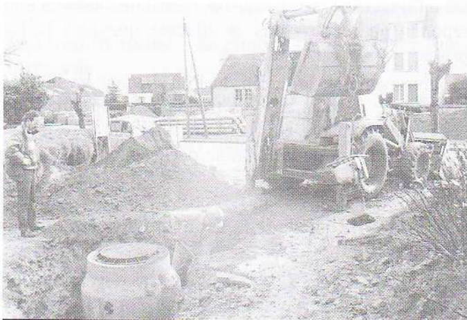
Les travaux d'assainissement rue de la Libération.
