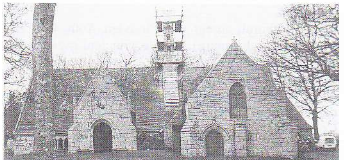
Une phase des travaux de consolidation du clocher de la chapelle Saint-Jaoua.
